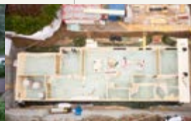
Erstes Untergeschoss aus Holz
