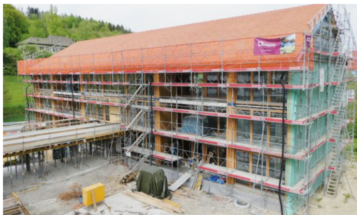
Der Neubau verbessert die räumlichen und betrieblichen Verhältnisse der Stiftung Brüttelenbad. TSI
